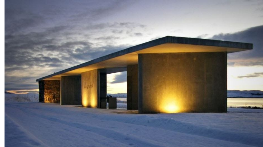
Áningarstaður byggður á rústum skotfærageymslu.
